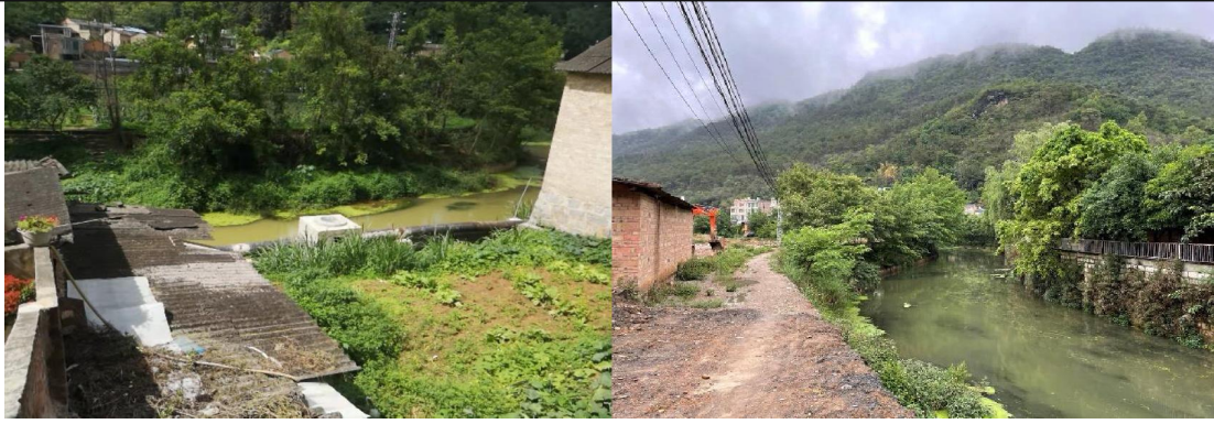
畴阳河河岸带被房屋侵占
