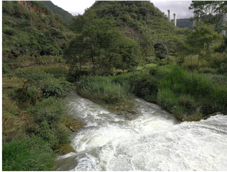
图 3-8 第一段河段治理起点，右岸为山体
