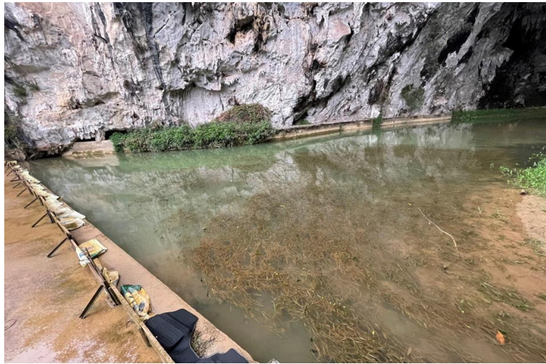
图 3-1 岔河燕子洞溢流堰损毁（上）及溢流堰前淤积（下）
