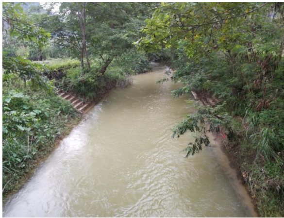
图 3-14 岔河溶洞出口以下已治理河道
