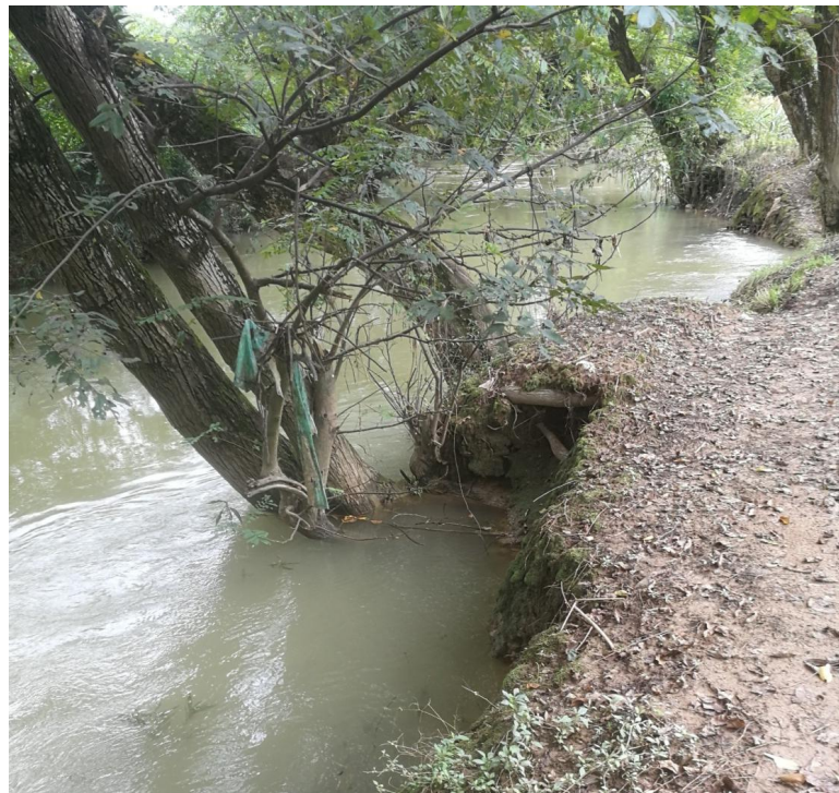
图 3-9 河岸受冲刷段
