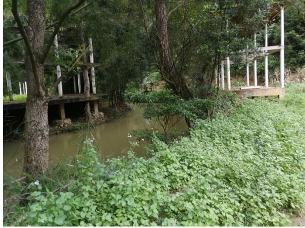
图 3-13 侵占河道行洪断面的违建
