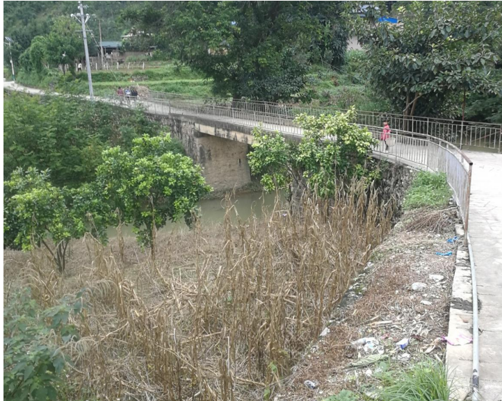
图 3-11 桩号 KY1+600 处现有农用桥
