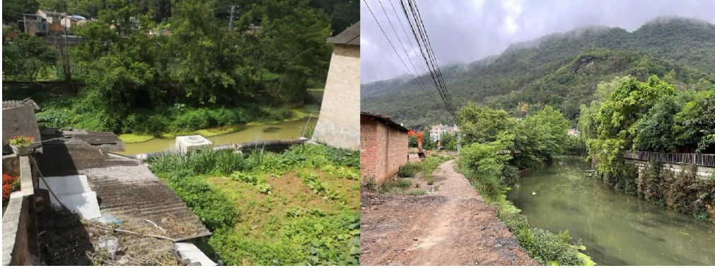
图 3-6 畴阳河河岸带被房屋侵占
