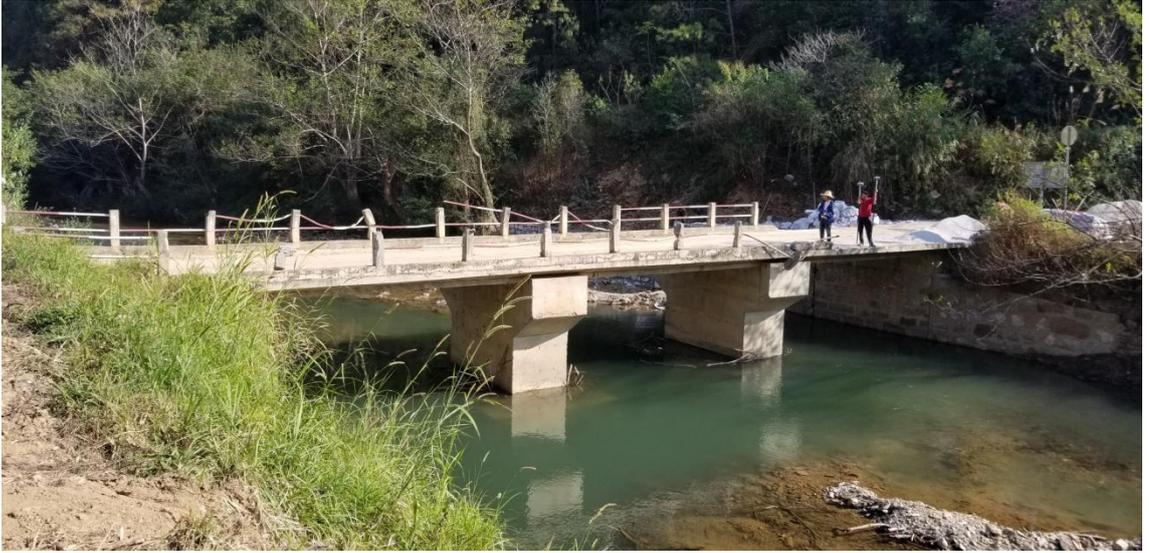
该桥桥孔跨度基本满足防洪要求，存在问题是桥孔高度不满足 10 年一遇行洪要求，被洪水冲刷造成桥面破损。处理措施拆除桥面板，加高桥墩，新建桥面板。
