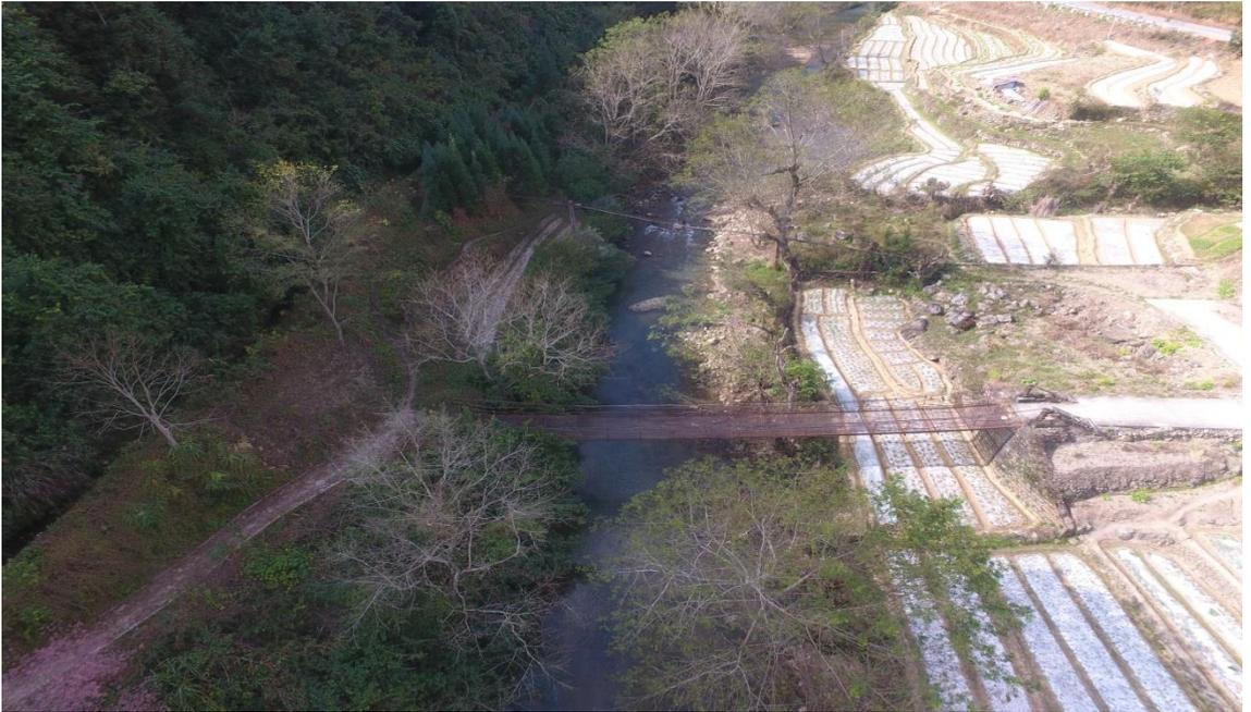
该桥桥孔跨度基本满足防洪要求，存在问题是两端均修建了水泥道路，车辆无法通行。处理措施拆除铁索桥，改建为钢筋混凝土农机桥。
