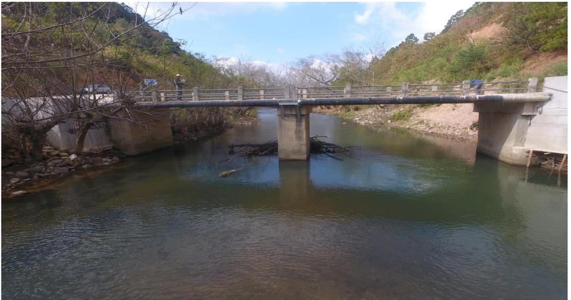
该桥桥孔净宽 15.0m，桥孔净高 4.1m，满足 10 年一遇行洪要求。维持原状，不处理。
