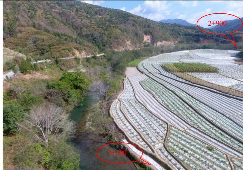
左岸为荒坡，无防洪保护对象，维持原状，不治理。右岸堤顶为农田，河岸被洪水冲刷呈较陡的边坡，垮塌现象较多，但堤坡上众多树木对堤坡有稳定作用。治理措施采用固滨笼护脚，雷诺垫护坡，并在堤顶修建混凝土道路。
